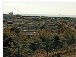
図3 石巻周辺はほぼ全壊となっている。
